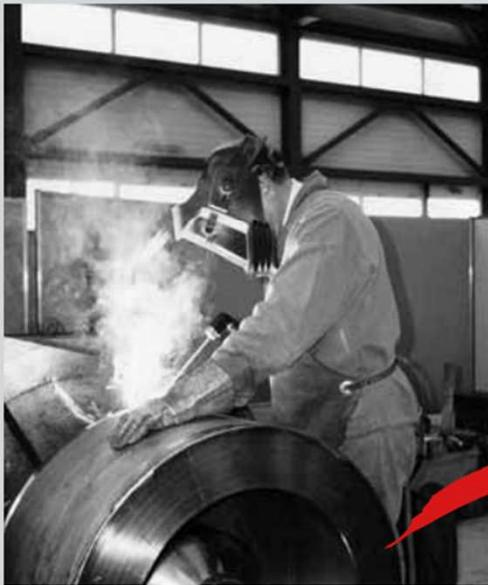
**Saldatura in gas protettivo**
